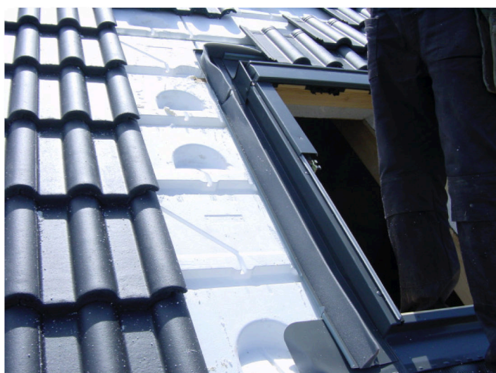
10. Montaža strešne obrobe
