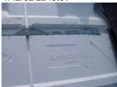
7. Montaža pločevine za odvod vode
